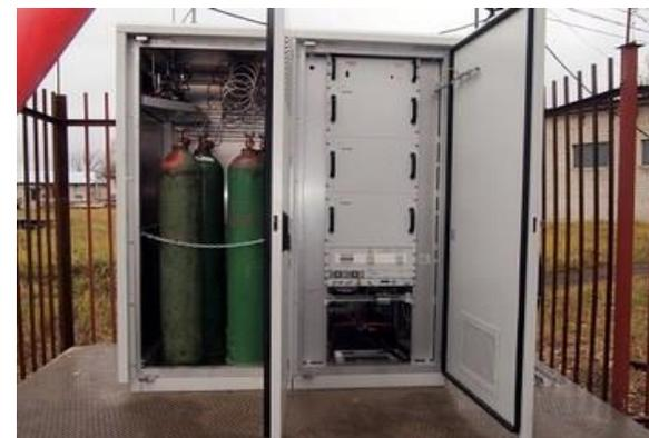
Система резервного электропитания «Астра» с ПОТЭ батареями на 50 кВт производство «Инэнерджи»
