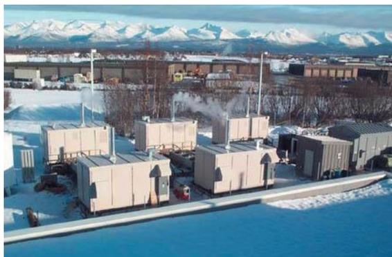
Система энергоснабжения дачного поселка (Аляска, США) на основе пяти батарей по 300 кВт производства «ONSI Corporation
